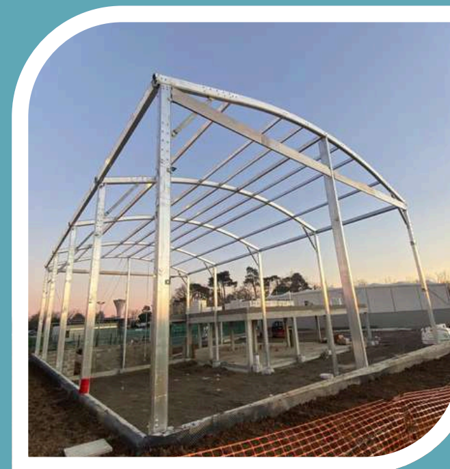
Construction du centre de padel à Camblanes-et-Meynac (33)
