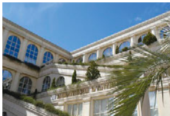
MONTPELLIER (34), «Les Échelles de la ville»
