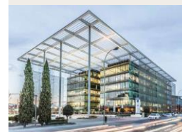
El Portico Madrid 21 000 m 2 de Bureaux
