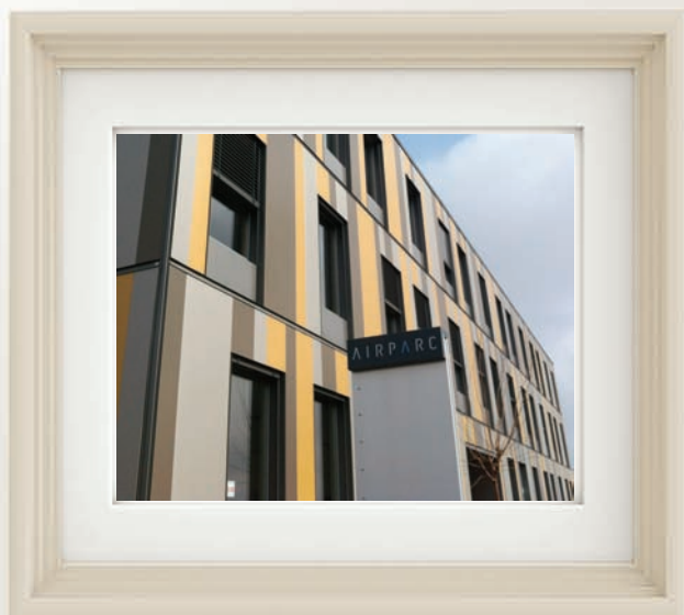
Airparc Lyon-Saint-Exupéry - 100, rue de Norvège COLOMBIER-SAUGNIEU (69)
