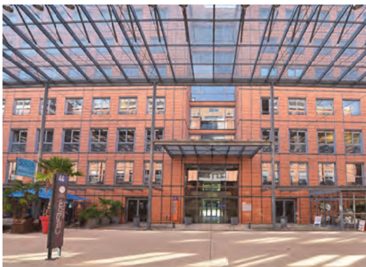
Cité Internationale - 45 quai Charles de Gaulle à LYON (6 ème ) - 437 m 2 de bureaux
