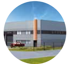
ACTI, Mitry-Mory, Bâtiment B - France
