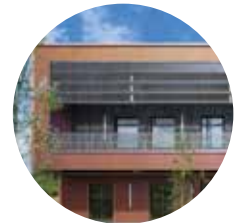
URBAN VALLEY, Massy, Bâtiment B - France
